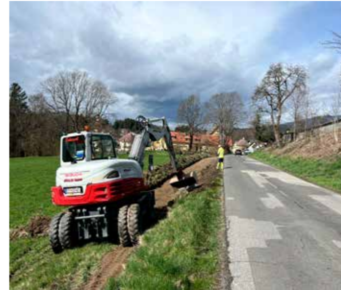
Bereits im Frühjahr wurde der Gehweg von Terlach nach Damschach fertiggestellt.
